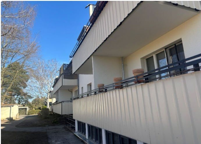
Balkonsanierung in der Egidystraße 27a abgeschlossen
