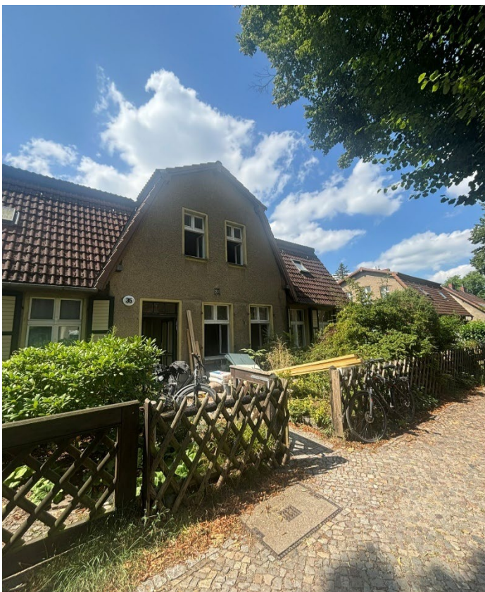
Eine Komplettsanierung der Egidystraße 35
