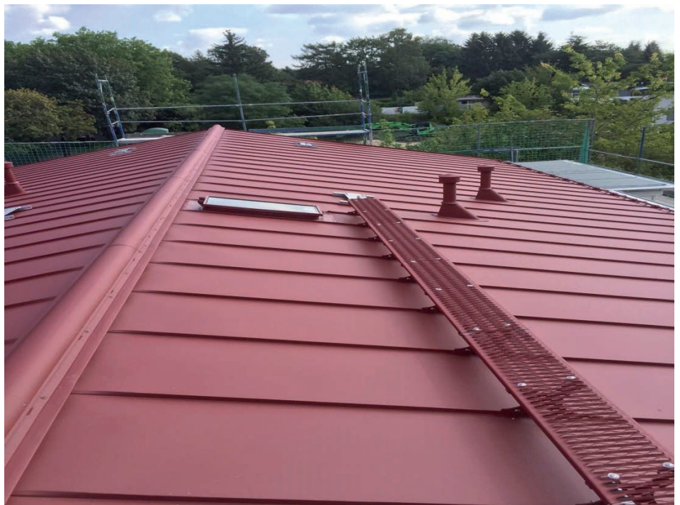
Neue Dacheindeckung Zabel-Krüger-Damm 86/90 (Schulze)
