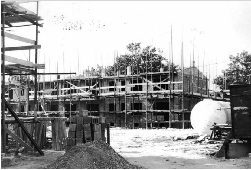
Zabel-Krüger-Damm 86/90; Aufnahme vom September 1960 (Archiv)
