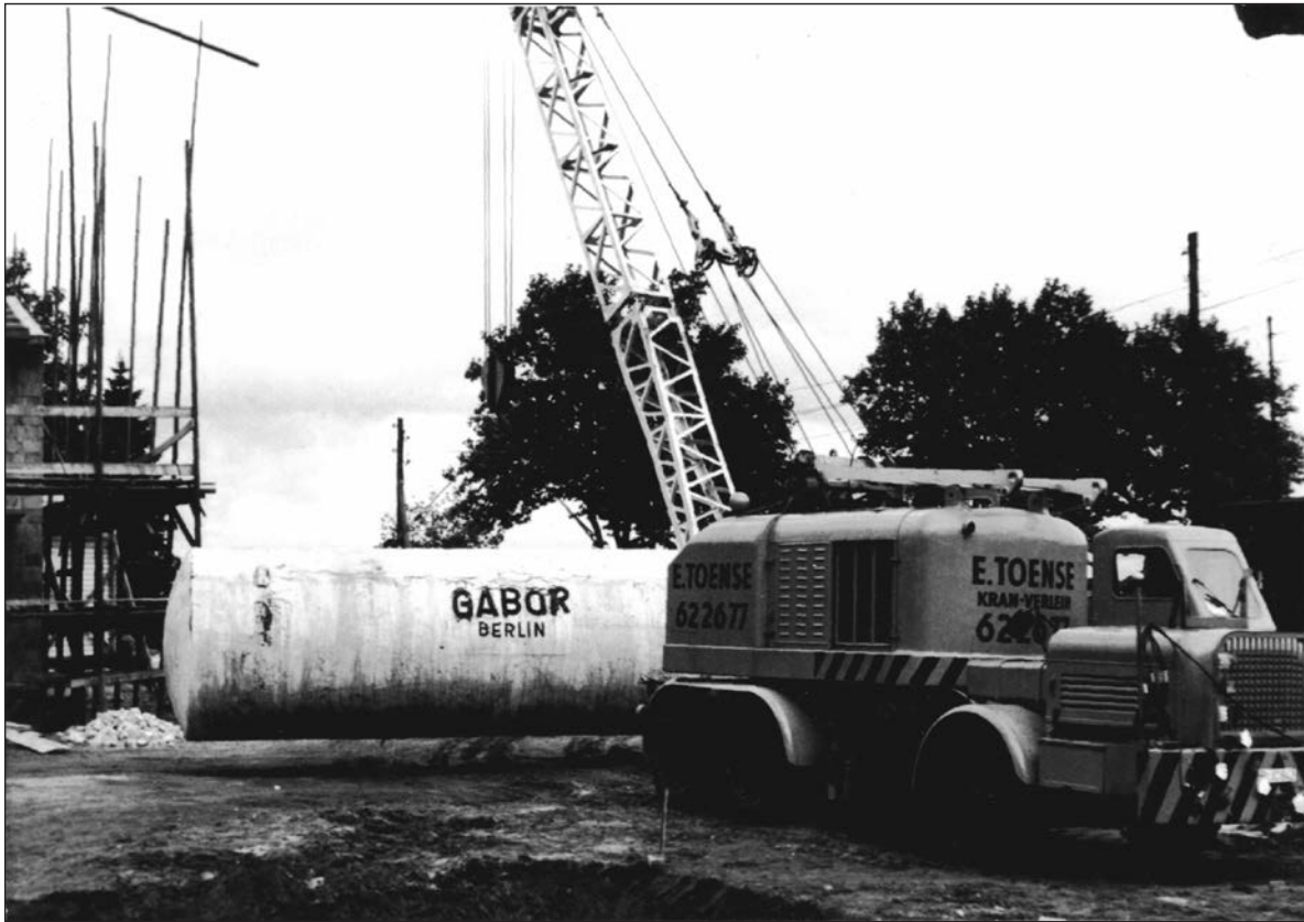
Einbau des Öltanks am 30.8.1960 (Archiv)
