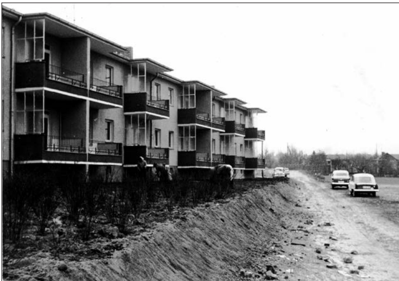
Zabel-Krüger-Damm 84 H-K; Aufnahme vom April 1961 (Archiv)
