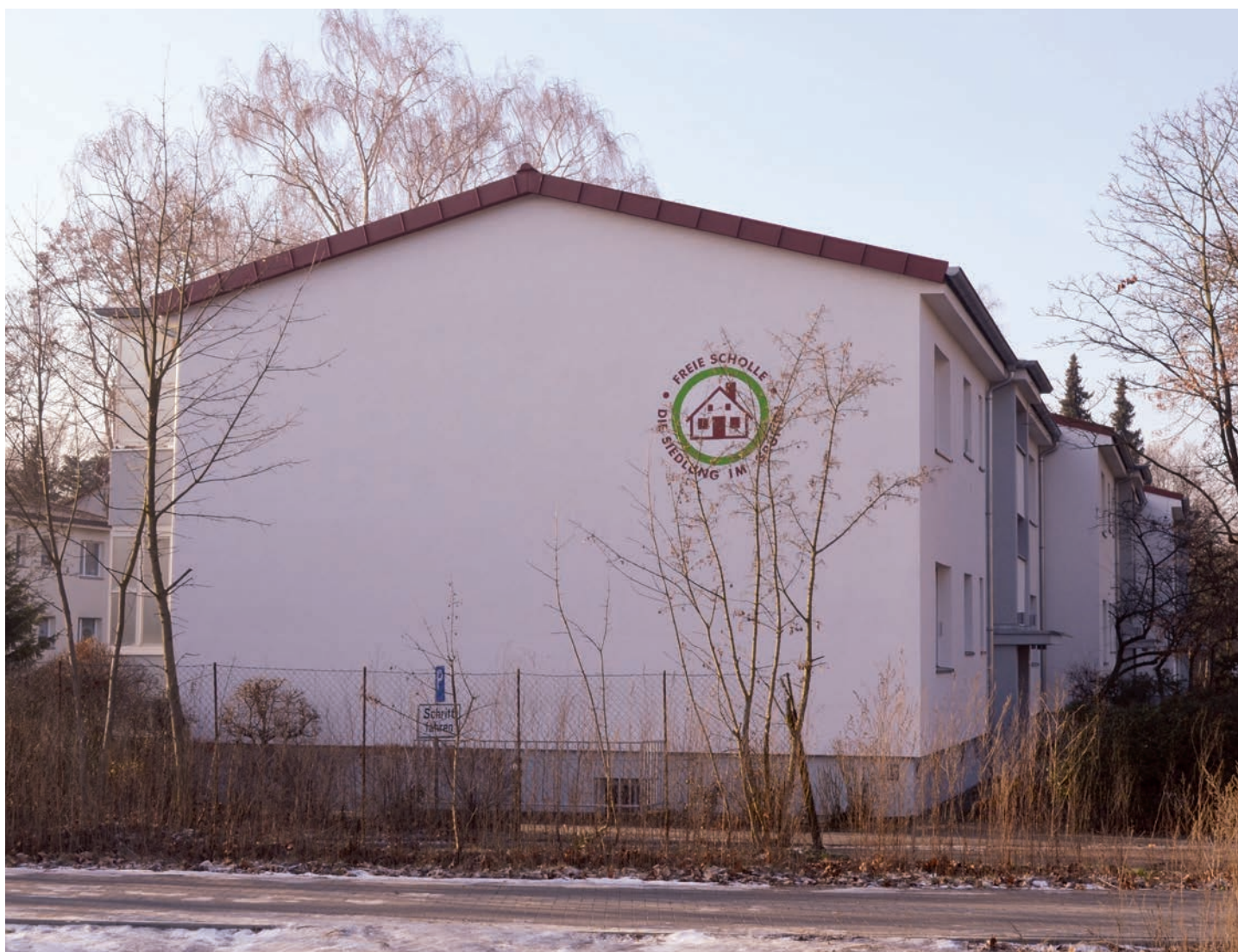
Giebel des Hauses Zabel-Krüger-Damm 90 nach Sanierung; Aufnahme vom Januar 2017 (Liepold)
