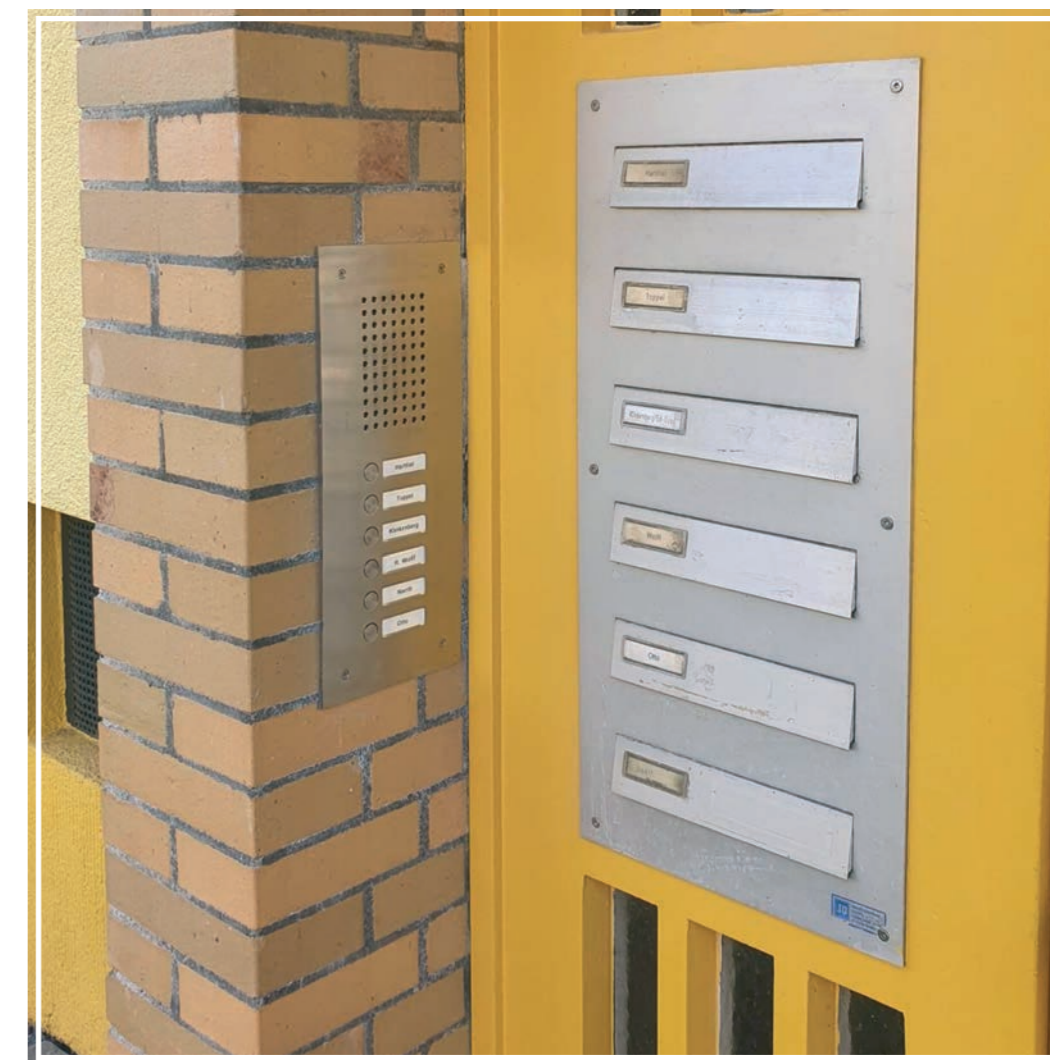
Neue Klingelsprechstellen in 13 Aufgängen in der Rosentreterpromenade
