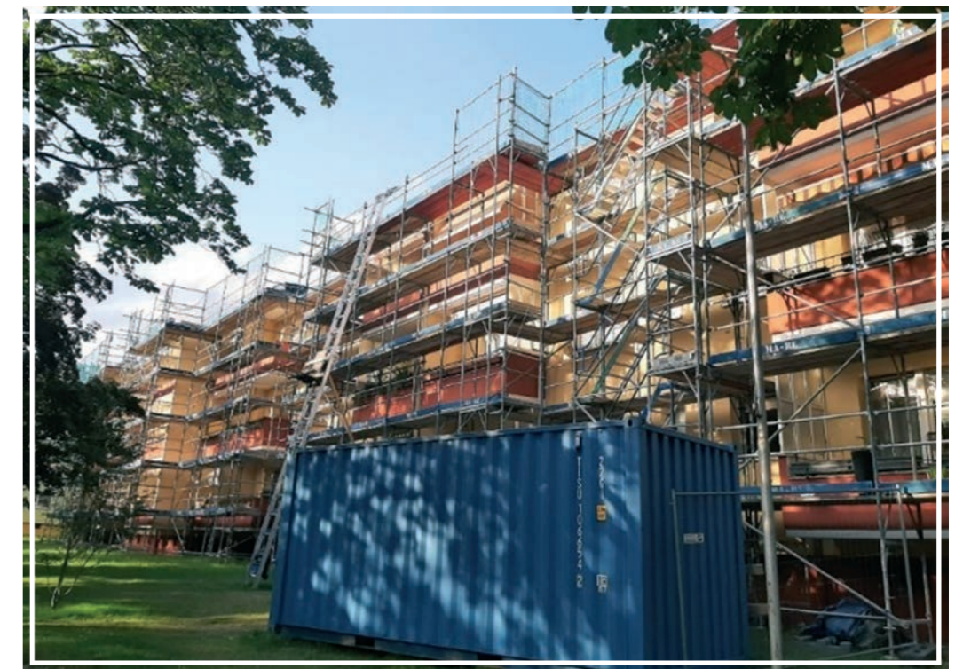
Dachneueindeckung und Malerarbeiten in der Rosentreterpromenade
