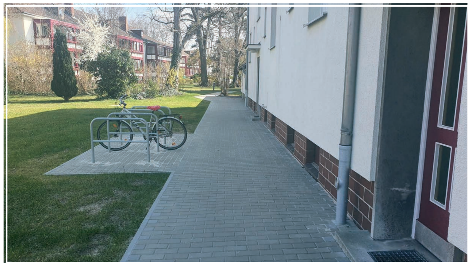
Erneuerung der Wege-, Parkplatz- und Müllplatzflächen in Alt-Wittenau/Hermsdorfer Straße
