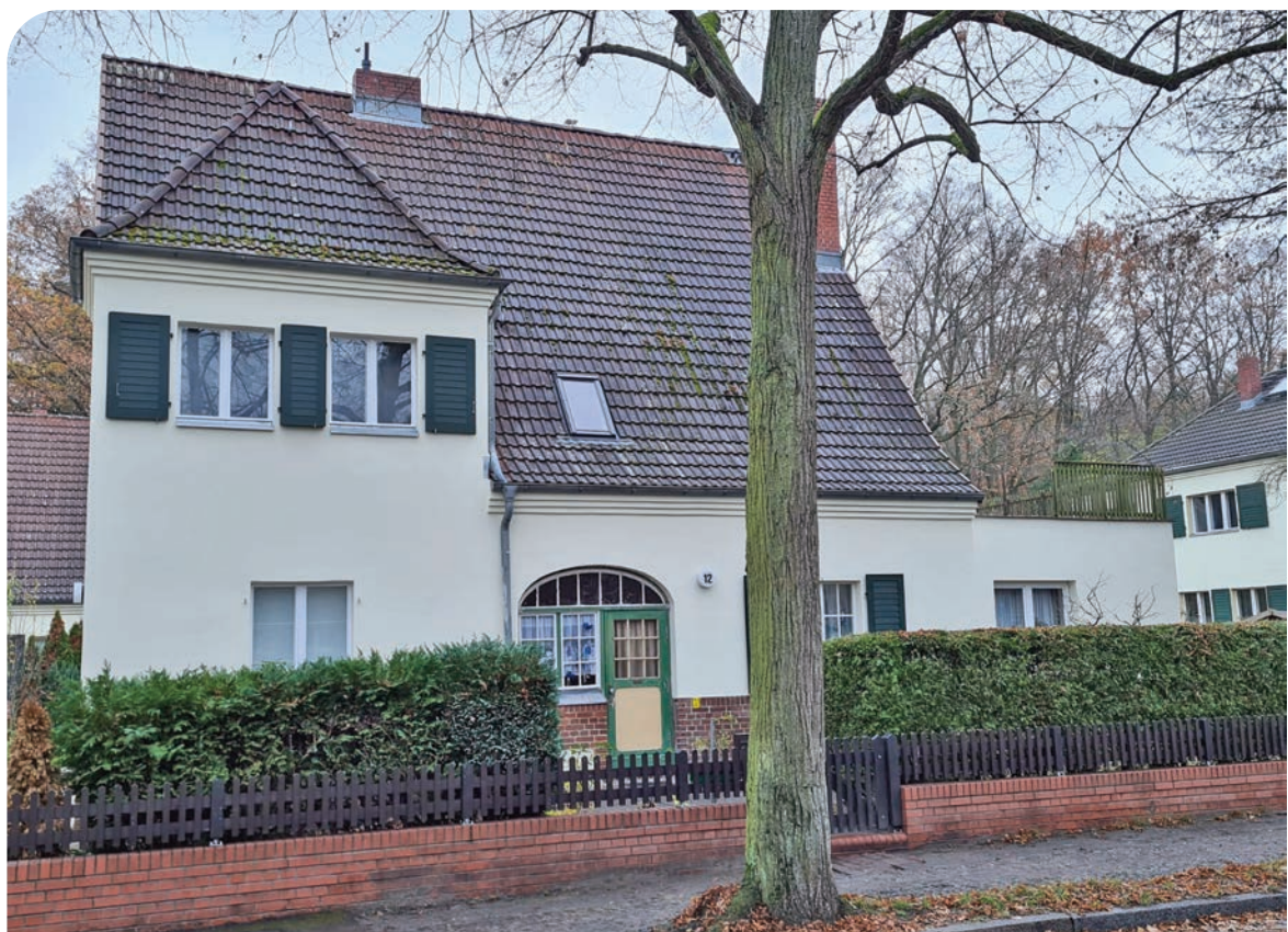
Sanierung des Einfamilienhauses in der Egidystraße 12
